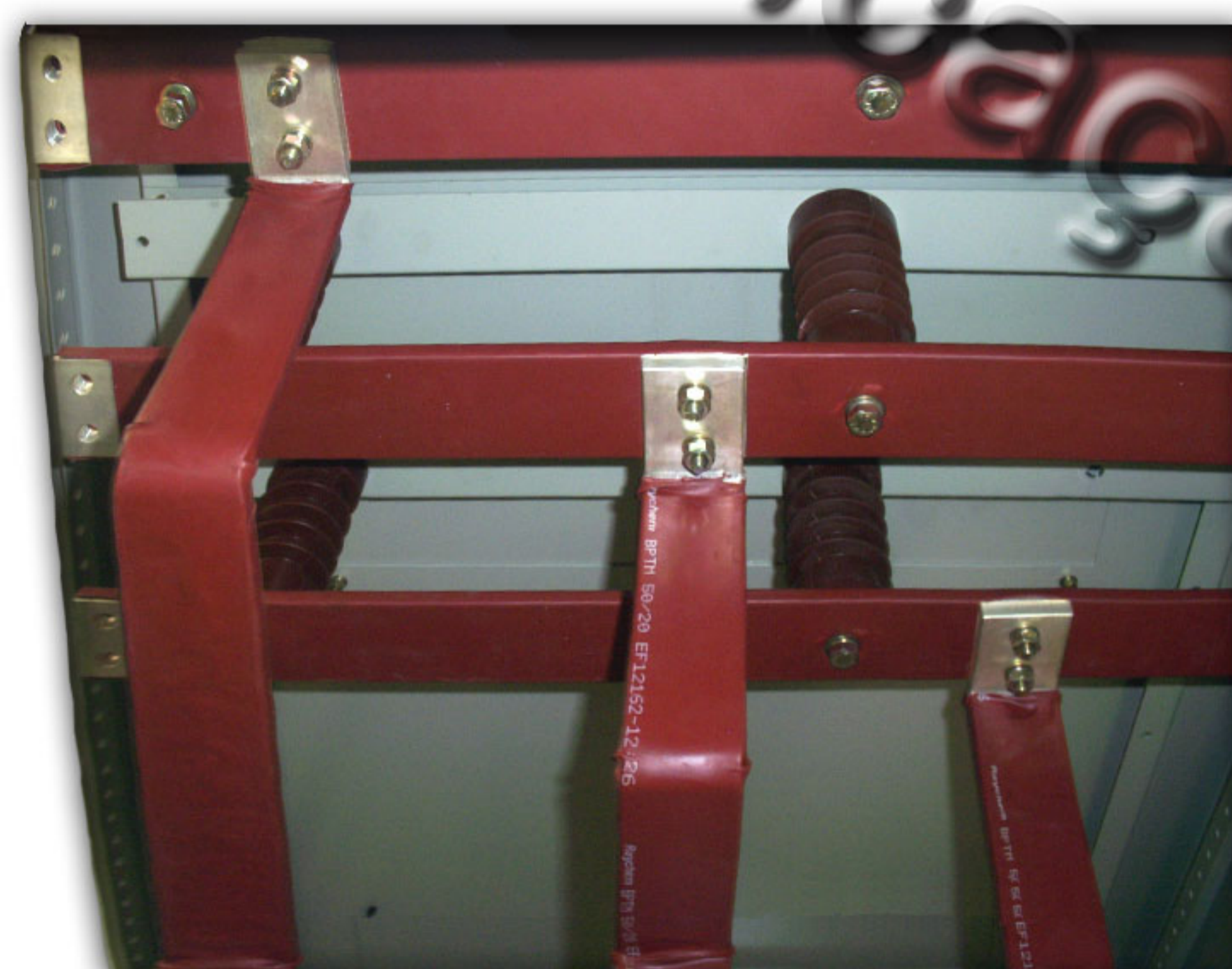
Detalhe do barramento isolado com termocontrátil - 15KV
